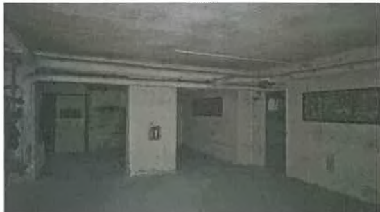
Vnitřní prostory Nemovitosti (1.PP)
