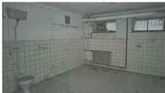
Vnitřní prostory Nemovitosti (1.PP)
