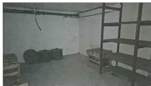
Vnitřní prostory Nemovitosti (1.PP)
