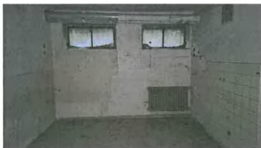
Vnitřní prostory Nemovitosti (1.PP)
