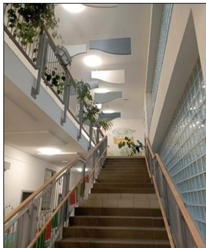
Nový akustický podhled v MŠ Hřibská
