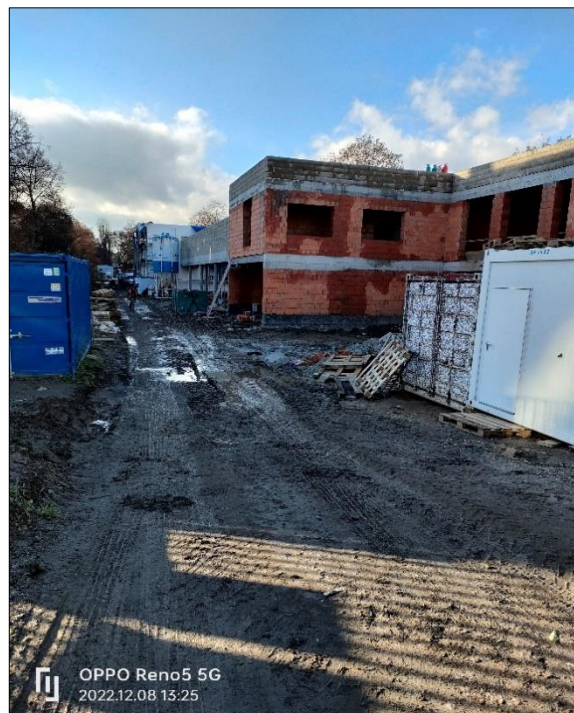
Výstavba nové MŠ v ulici Bajkalská
