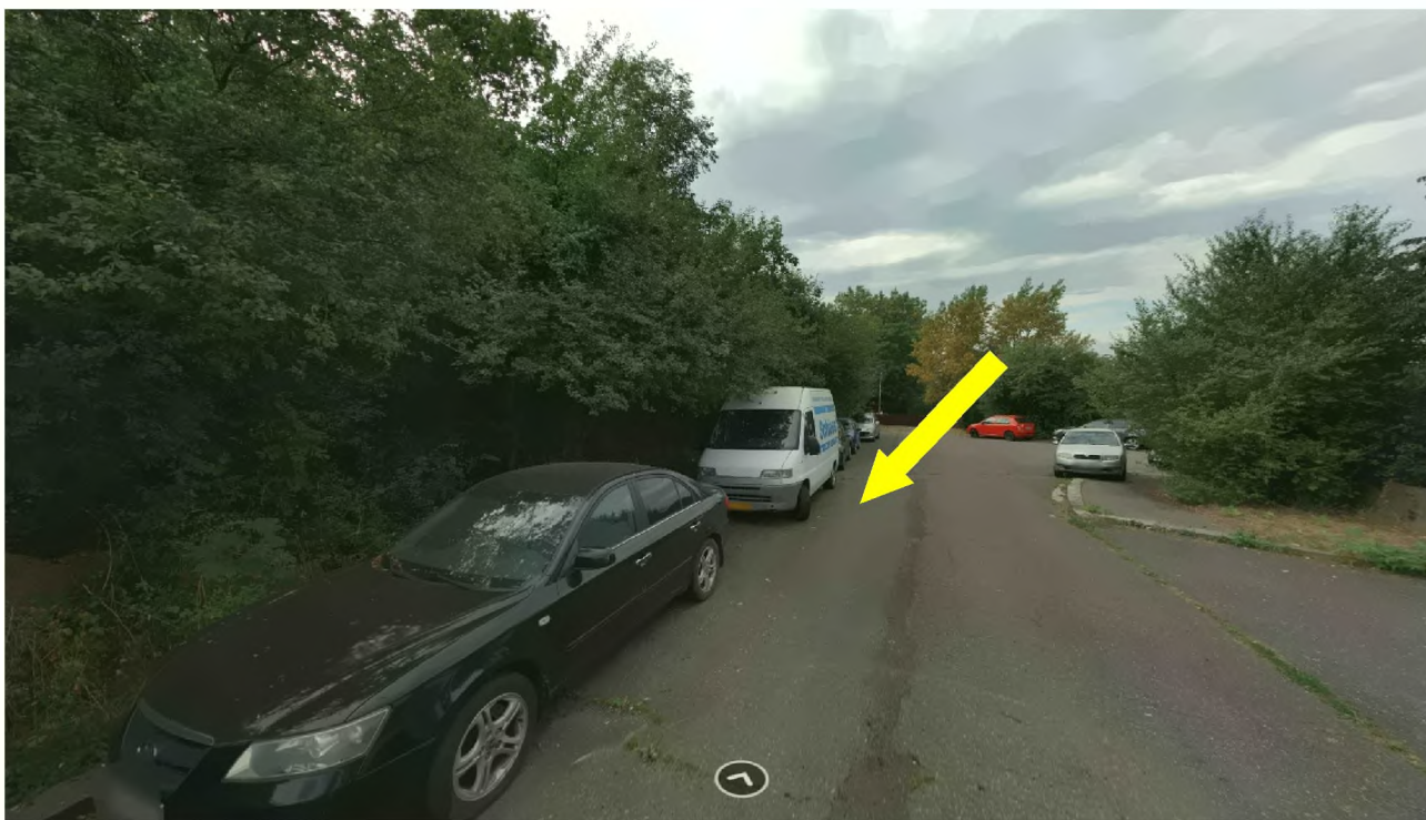
Pohled na pozemek parc. č. 5867/3 z Žirovnické ulice (pozemek je součástí asf. komunikace)
