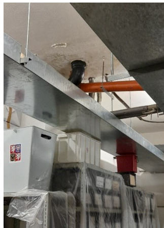
Foto. 2 Havárie - Výměna odpadu v prostorech archivu
