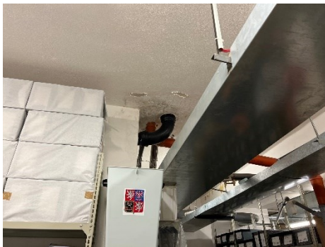
Foto. 2 Havárie - Výměna odpadu v prostorech archivu
