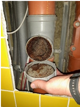
Foto. 2 Havárie - Výměna odpadu v prostorech archivu
