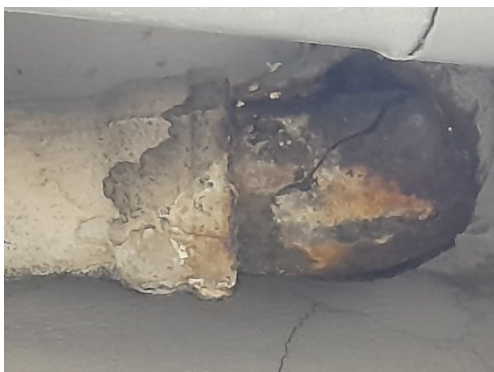
Foto 3 - Havarijní oprava litinové stupačky na dámském WC A 4. P, C119 a C přízemí
